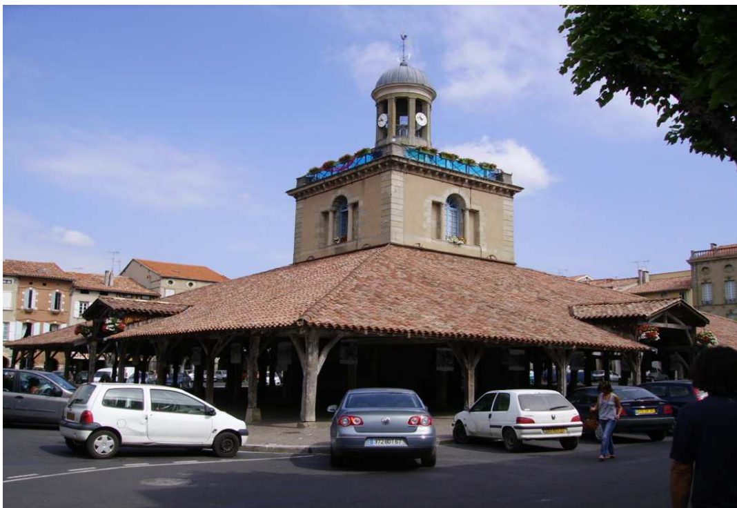
La halle centrale © J.L. Rougier.
